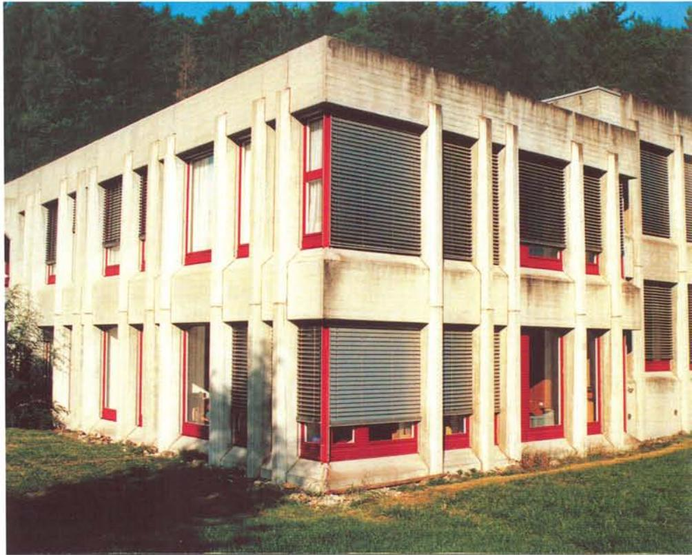
Je poröser die Oberfläche, desto gefährdeter ist die Fassade. Beton erfordert deshalb eine besondere fachmännische Pflege.
