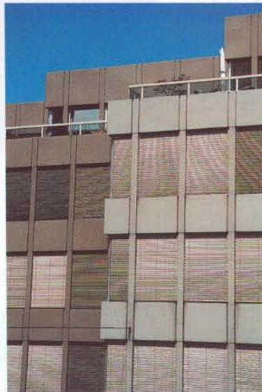
Verschiedene Umwelteinflüsse können die Schutzschicht der Fassade zerstören. Die Materialien werden porös und verschmutzen. Der anfangs oberflächliche Schmutz frisst sich immer tiefer in die Materialschichten. Vom Fachmann gereinigte und gepflegte Fassaden sind deshalb nicht nur ein Schönheitsetikett. Materialgerechte Fassadenreinigung wirkt werterhaltend und hilft langfristig mit, grössere Schäden zu vermeiden.
